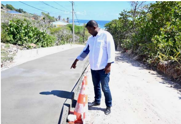
Travaux routiers à la Désirade
