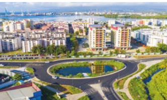
Aménagement de la RD 126 p.114
