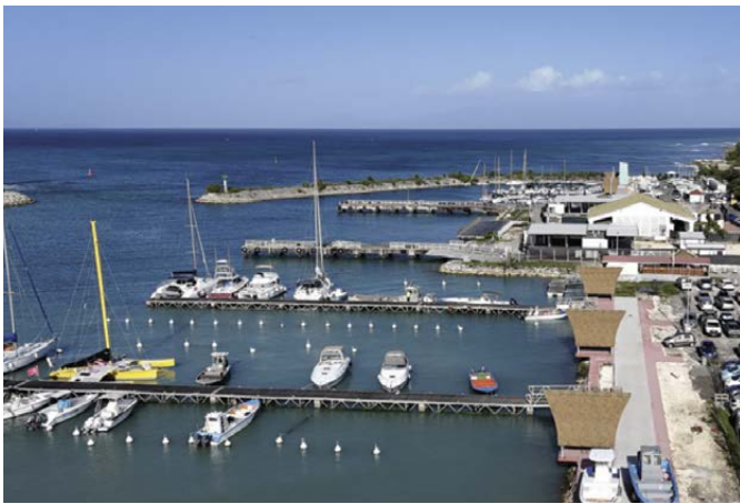
Travaux du port de Grand-Bourg de Marie-Galante
