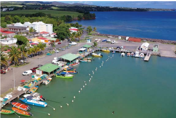
Aménagement du port de Sainte-Rose
