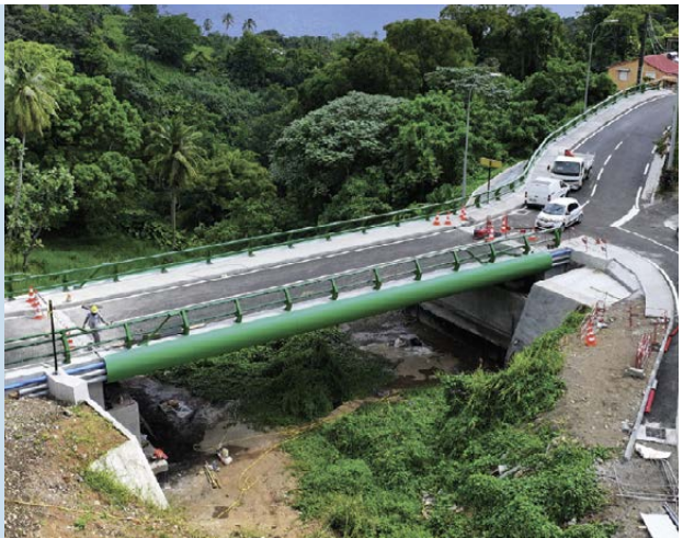
Travaux de réhabilitation du pont Ravine La Source à Trois-Rivières
