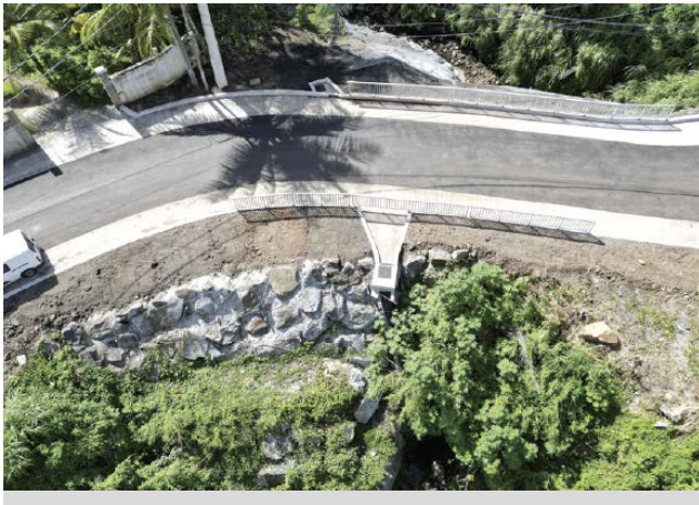
Travaux routiers à Champfleury Gourbeyre
