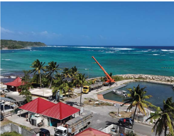
Travaux du port de Capesterre-de-Marie-Galante
